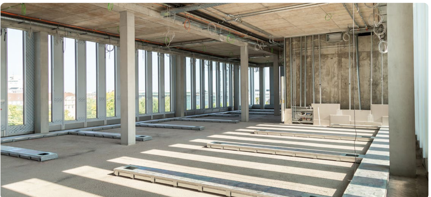
Estrichbündige Bodeninstallationskanäle von PohlCon zur flexiblen Leitungsführung in einem Rohbau-Bürogebäude.
